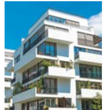
Protection de balcon, immeuble d'habitation
