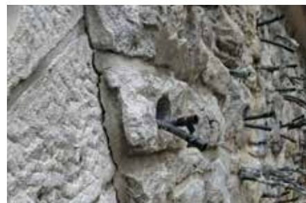
Maçonnerie préparée pour le remplissage
