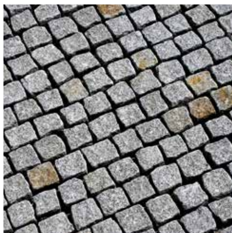
Pré-humidifier généreusement les éléments de fixation avant le jointoiment.
