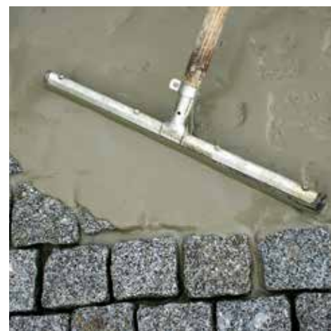
Appliquer le mortier de jointoiment hautement fluide et autocompactant.
