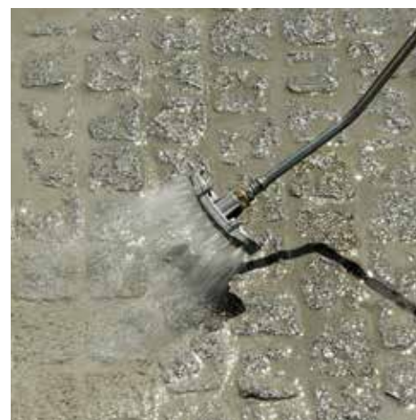
Rincer pour éliminer le mortier de jointoiment de la surface pavée.
