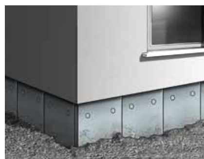
Maçonnerie (socle isolé)
