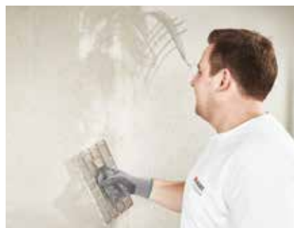
Renforcer des enduits allégés
